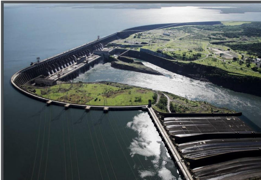
• Itaipu, Mauer h = 120m, l = 8 km, Fläche = 2 x Bodensee, 14 GW, ~ 100 TWh • Die 10 verbliebenen deutschen KKW (2015) zusammen: 13 GW
